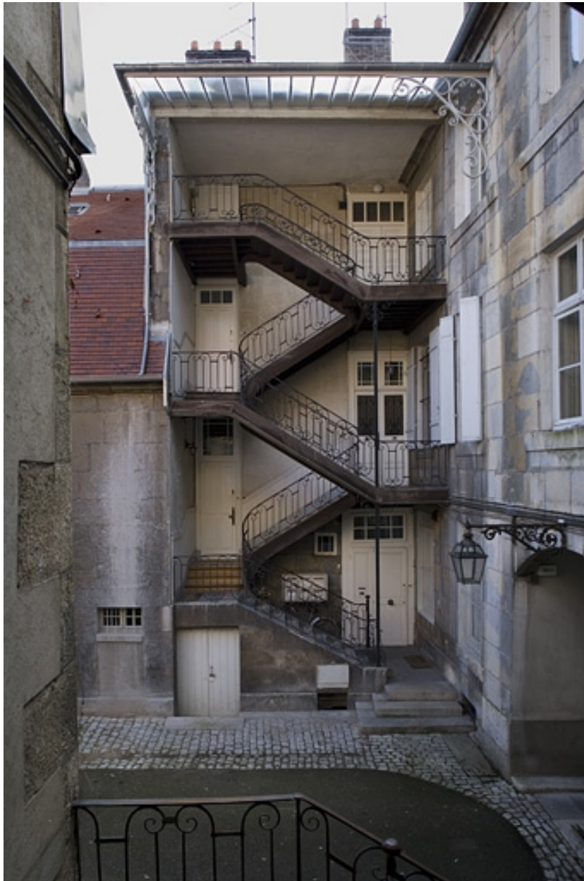
Vue d'ensemble de l'escalier à cage ouverte à gauche de la cour.
