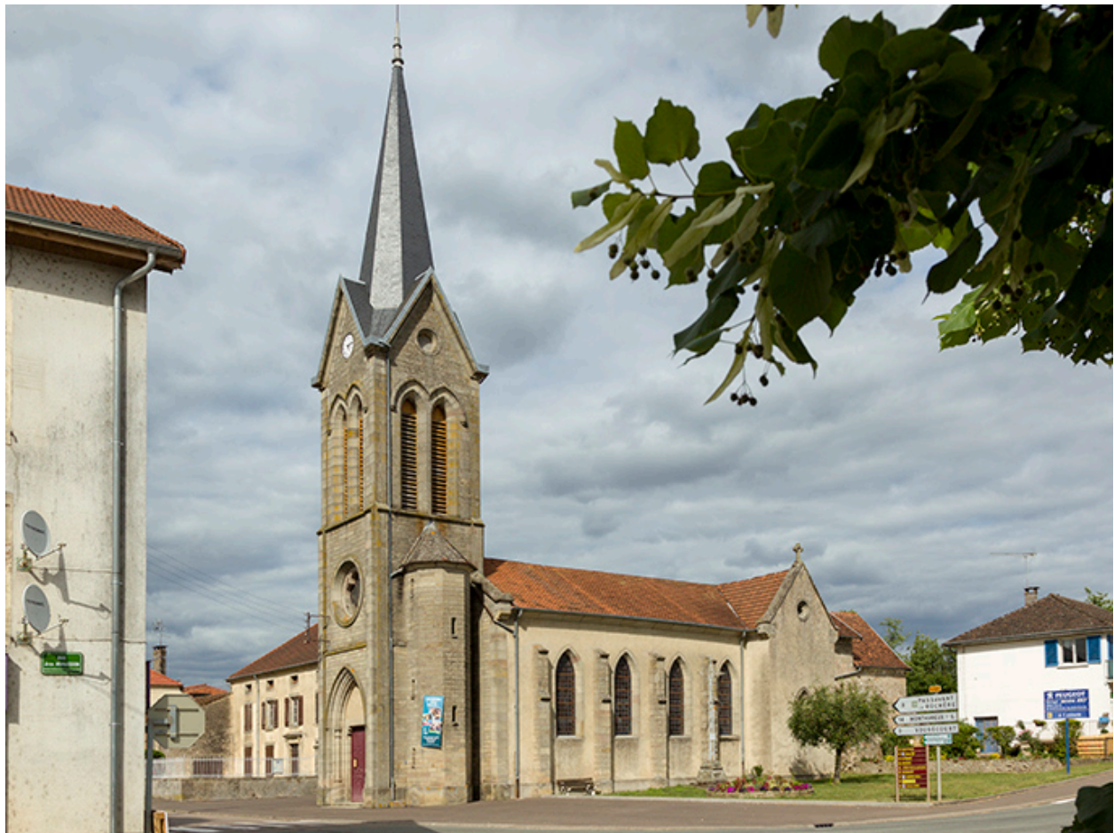
Vue d'ensemble sud-ouest.
