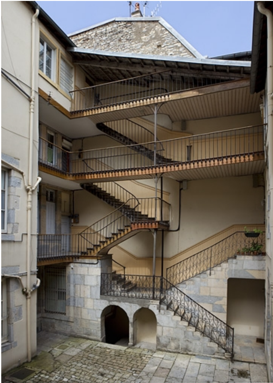
Vue d'ensemble de l'escalier à cage ouverte sur cour.
