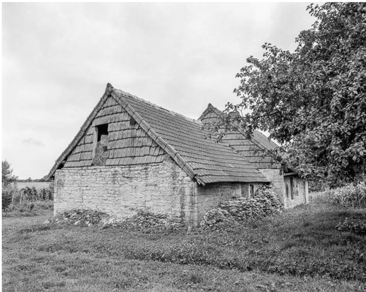
Façade postérieure et pignon droit.
