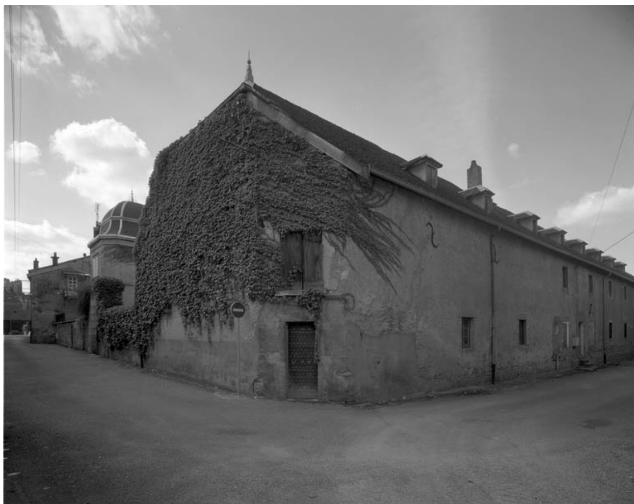
Façades postérieure et latérale droite de l'entrepôt.
