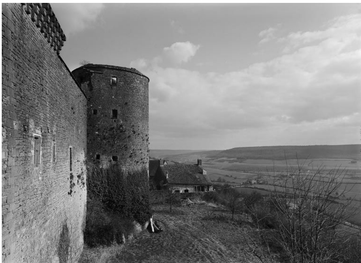
Enceinte : tour d'angle. Vue de l'extérieur (photo prise en 1969).
