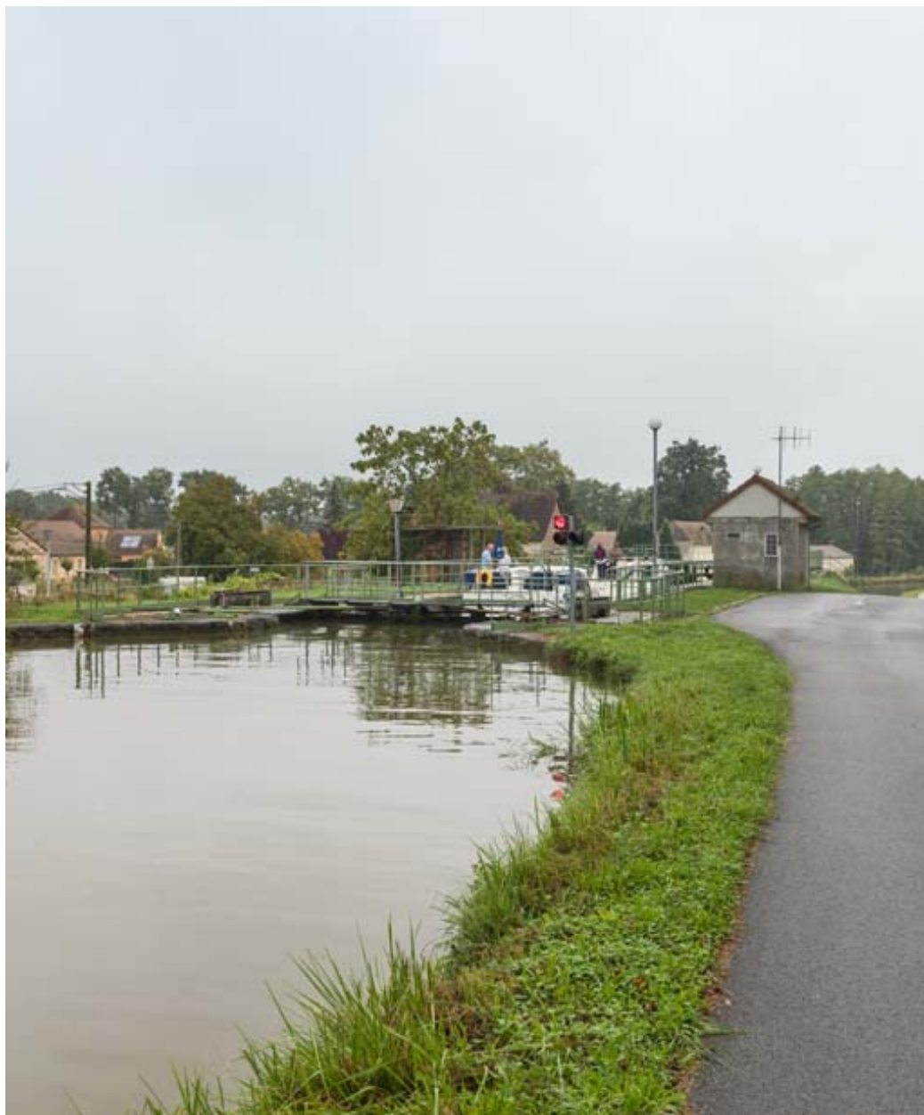
Vue d'ensemble du site d'écluse.
