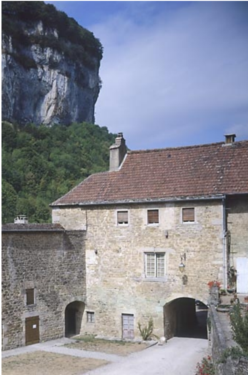
L'hôtellerie : partie gauche de la façade sud ouest.
