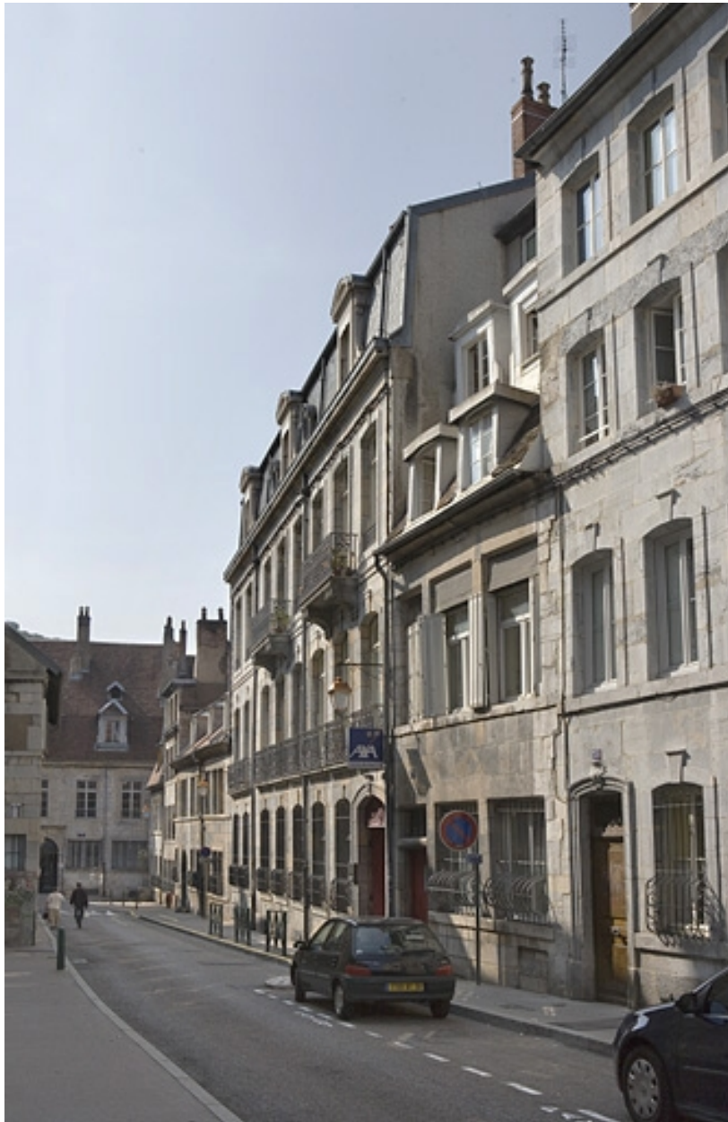
Vue d'ensemble du logis principal dans l'alignement de la rue.
