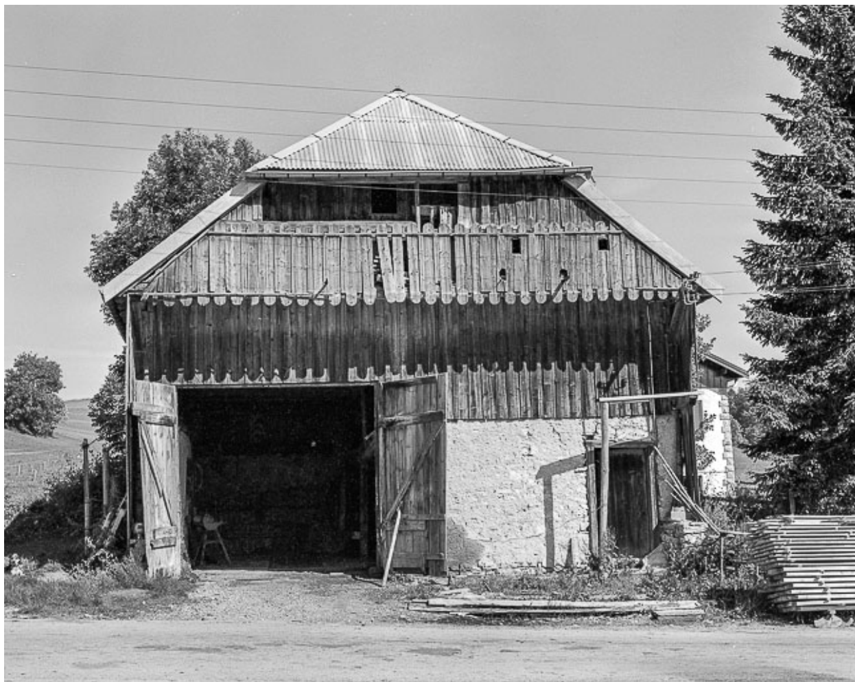
La remise, vue de face.
