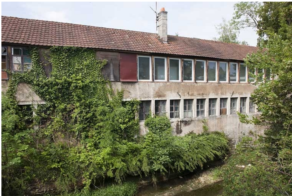
Façade sur le Gland de l'atelier d'horlogerie.
