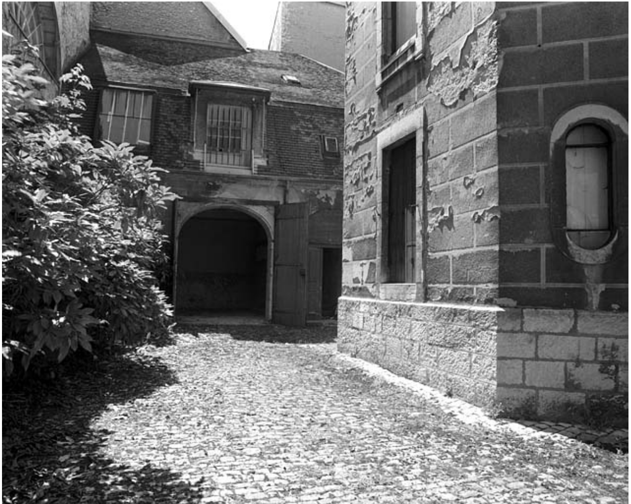
Vue du bâtiment des remises, de face.
