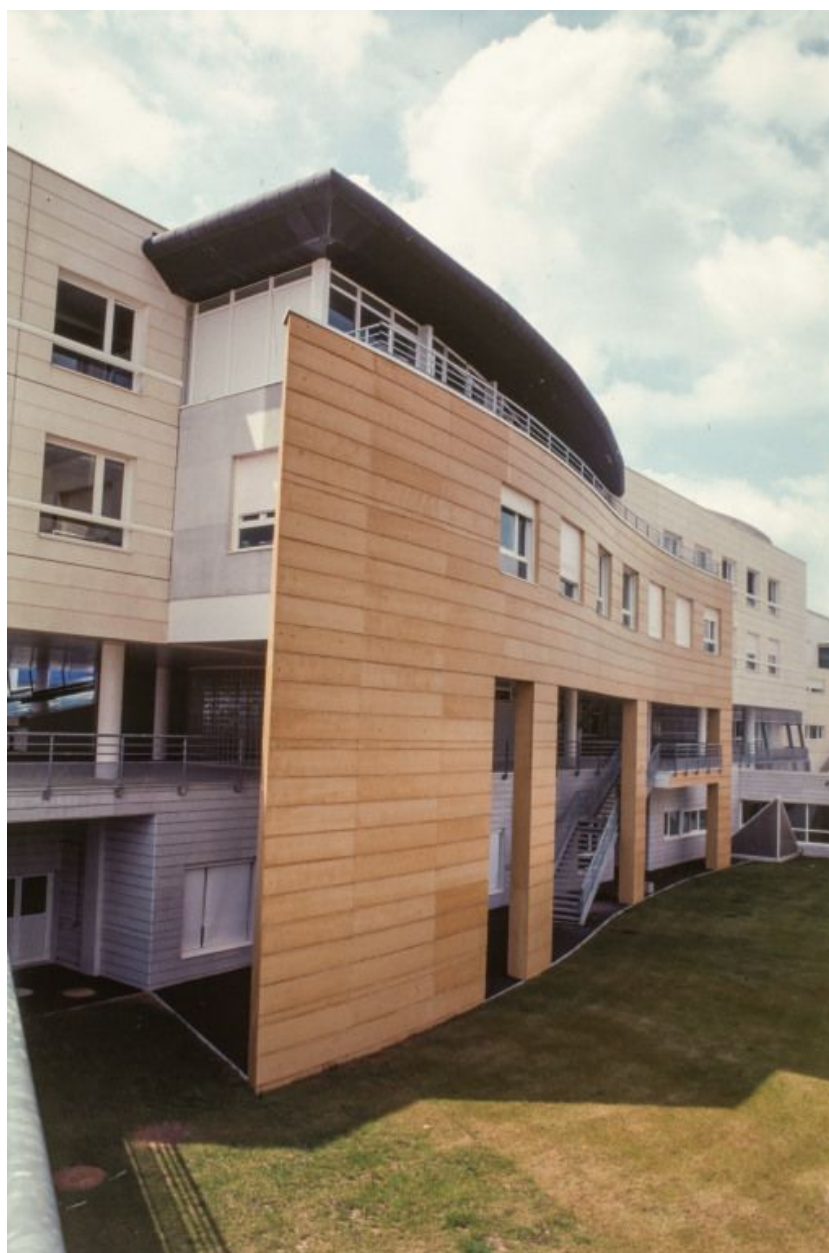
Façade antérieure, détail de la partie gauche.
