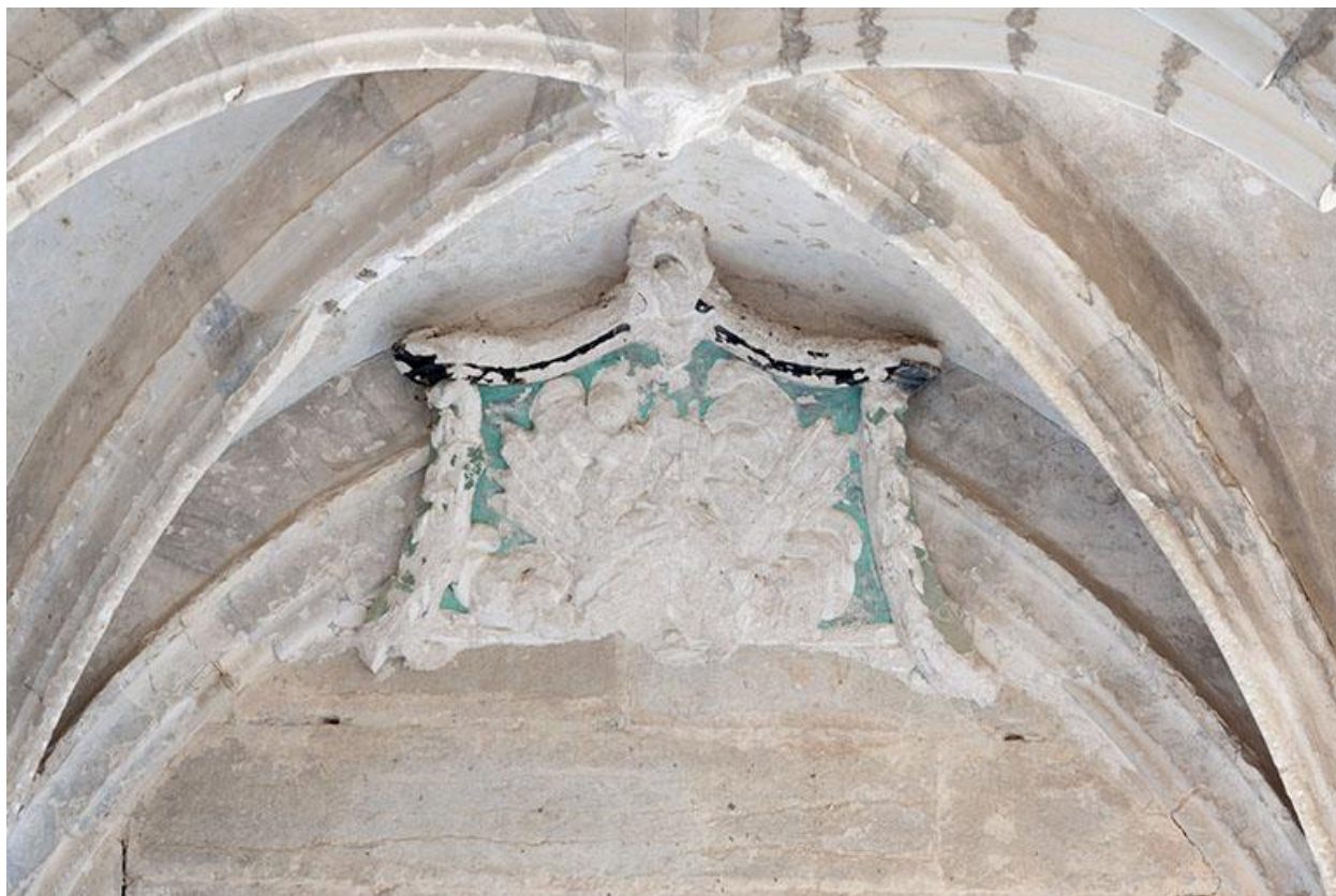
Décor de stuc situé sous la galerie
