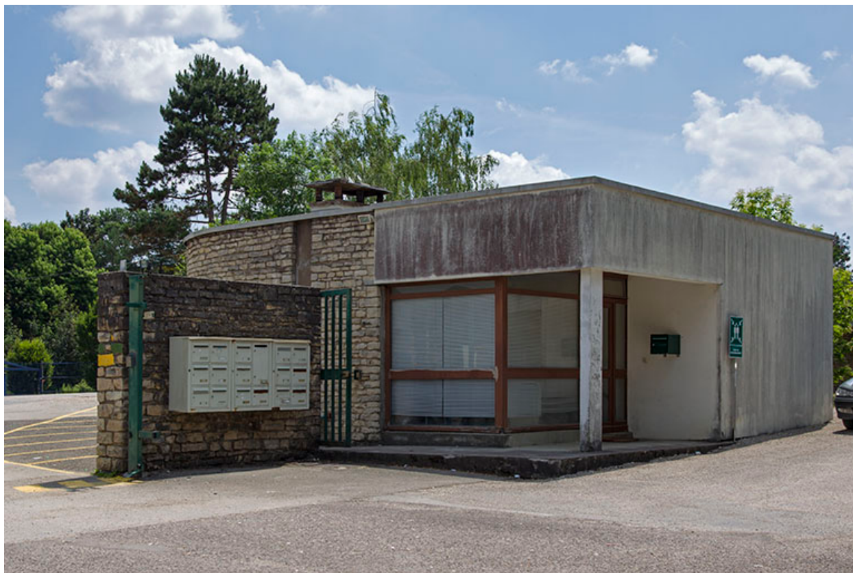
Loge d'entrée vue du nord-ouest.
