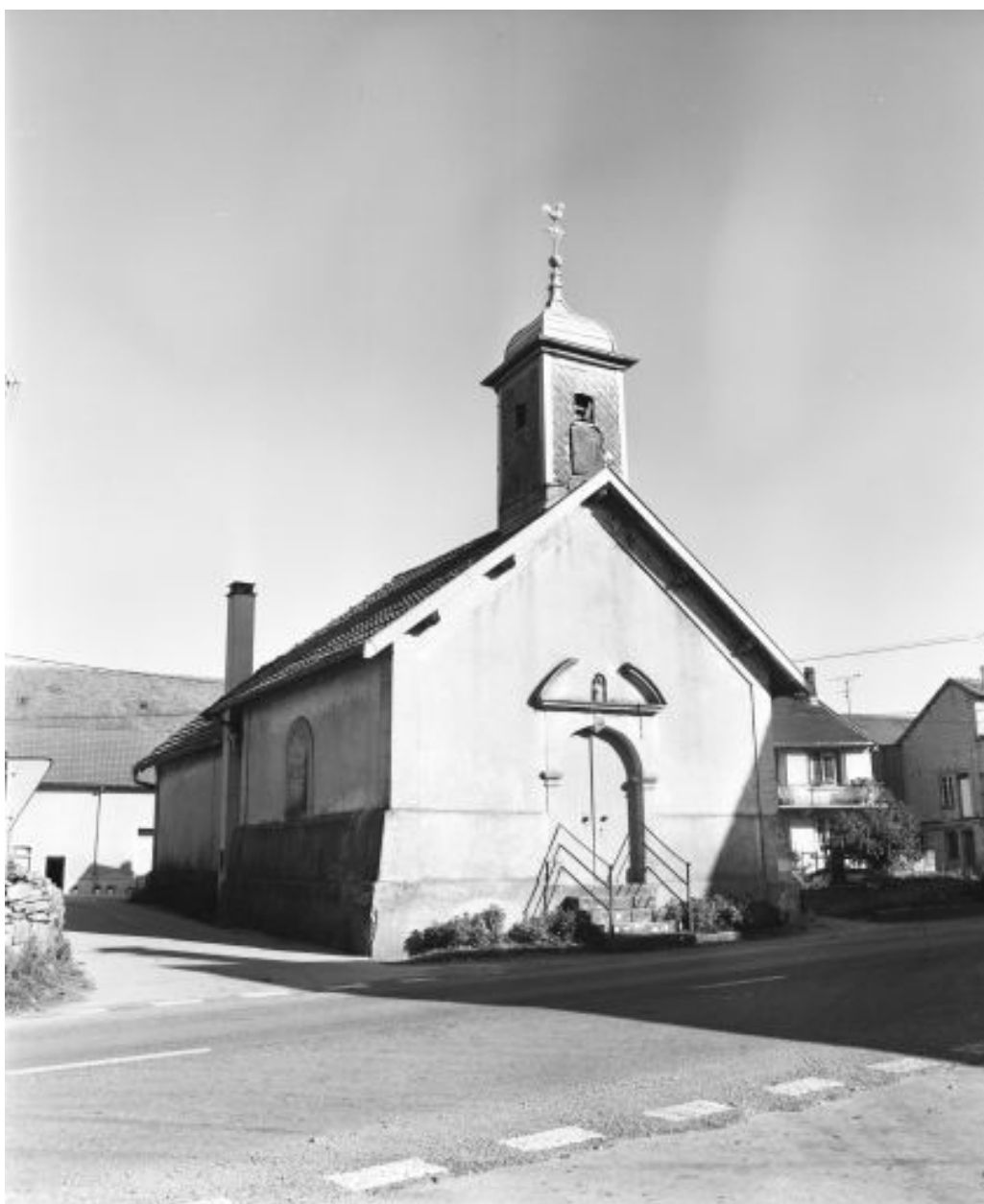
Vue de la façade antérieure.
