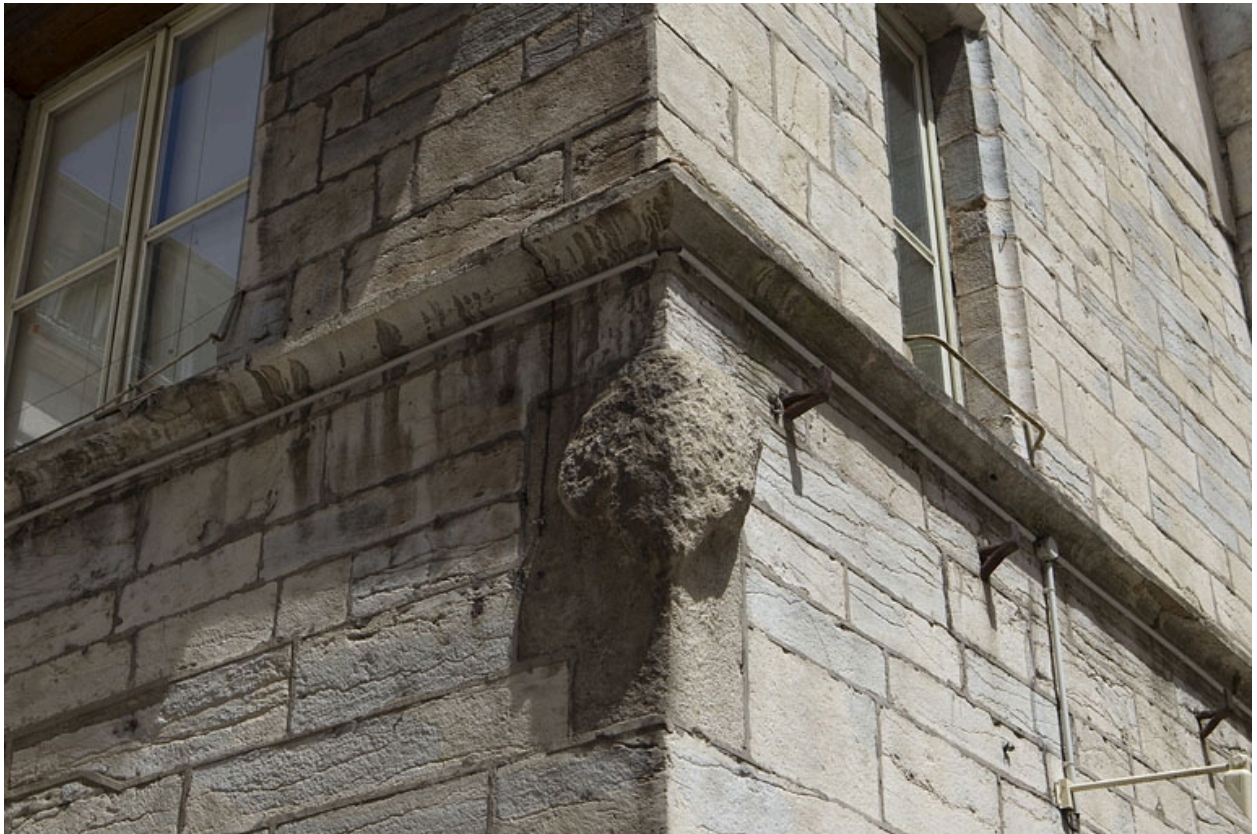
Logis principal, façade sur rue : détail des armoires bûchées.
