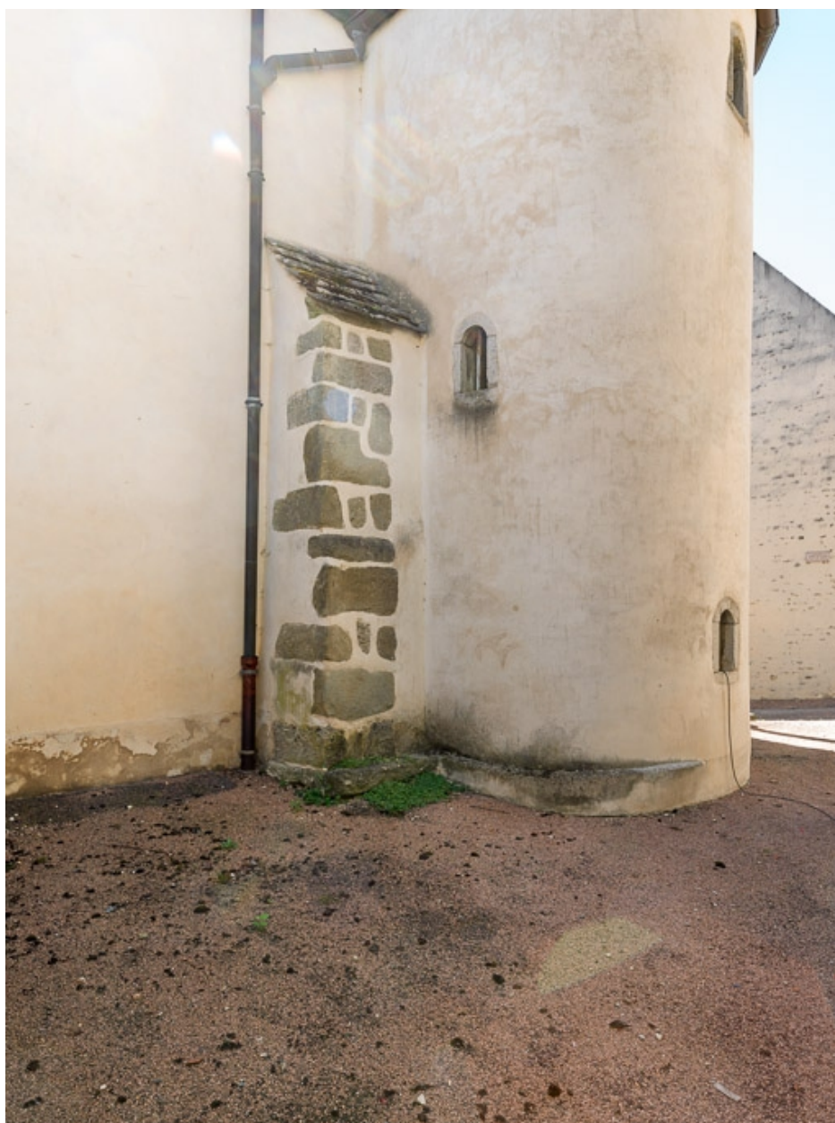
Détail de la tourelle d'escalier.
