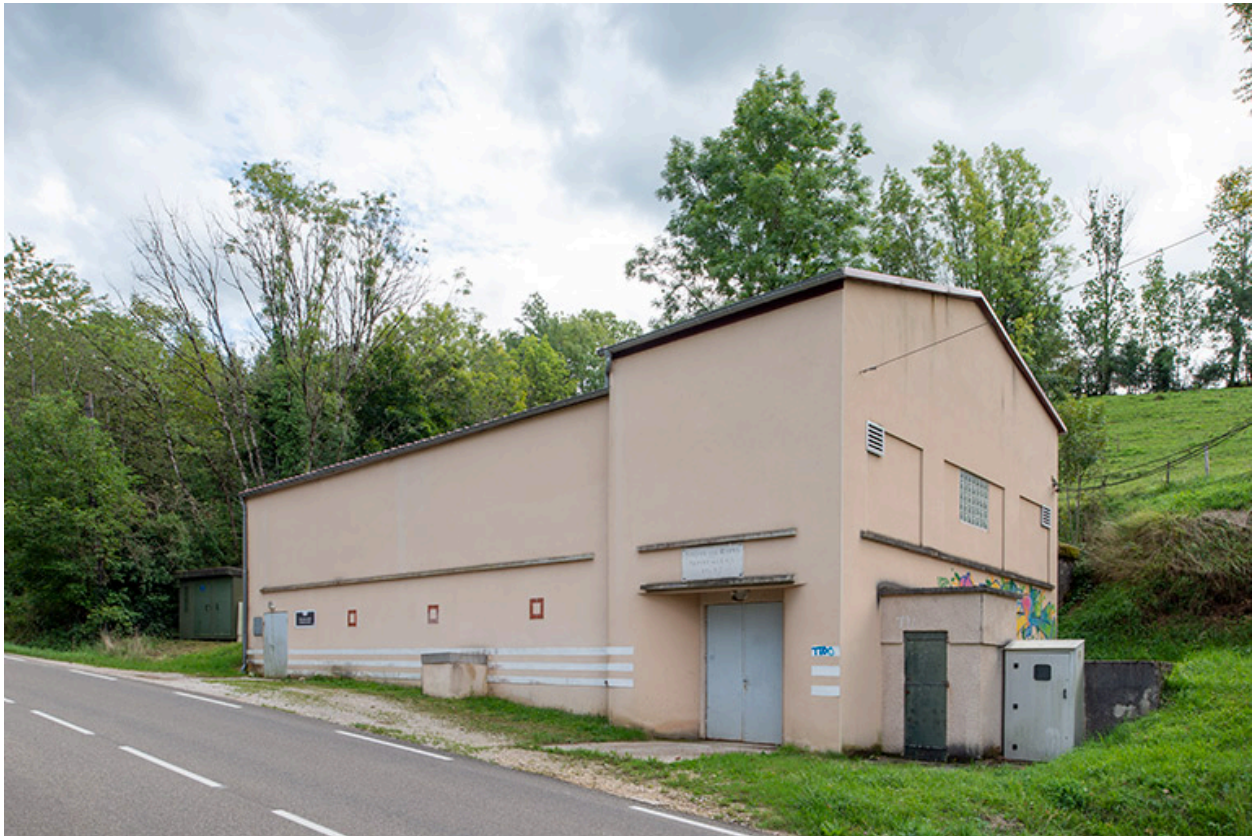
Station de stérilisation (1937), R.D. 472.
