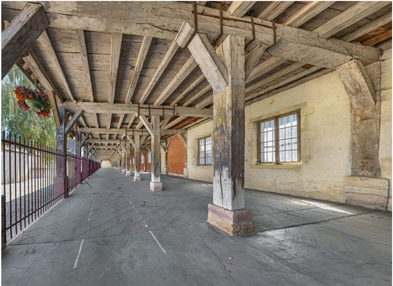
La charpente du hangar.
