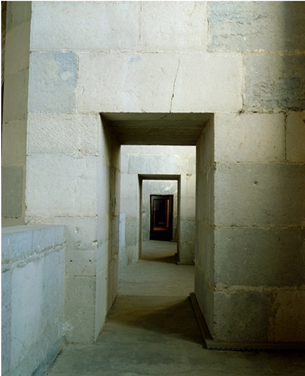
Passage établi au droit de la pile 3S dans la coursière du collatéral sud.
