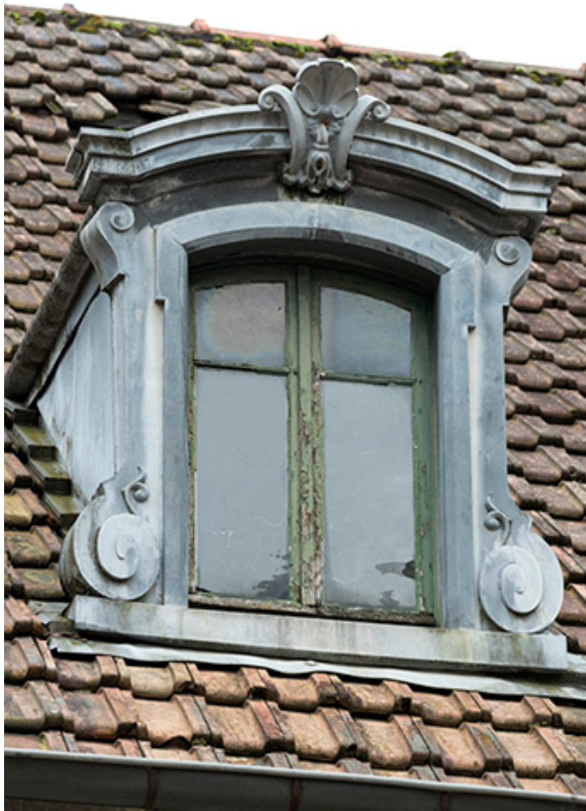
Etat en 2016. Usine A : lucarne des bureaux.
