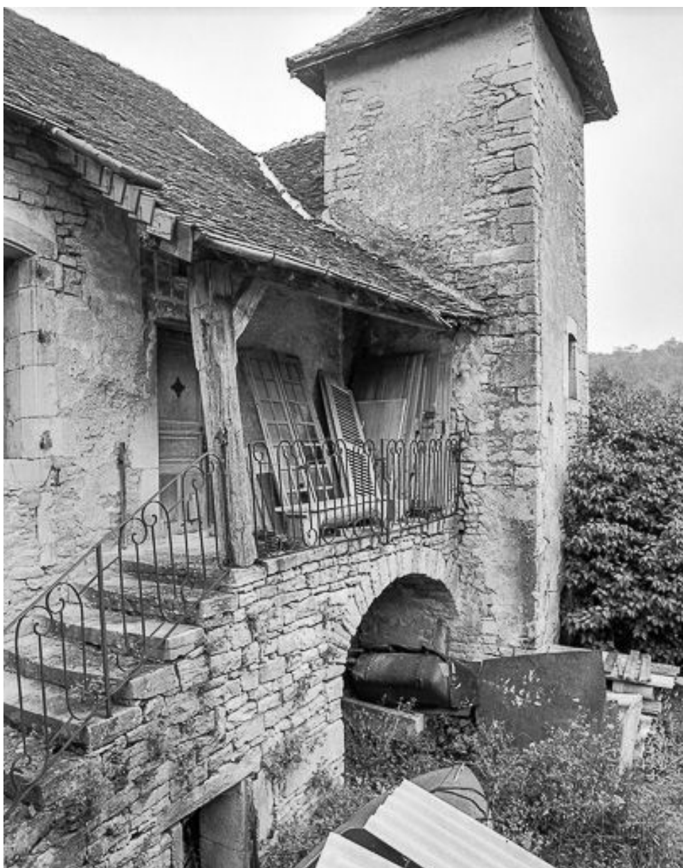
Auvent protégeant l'escalier.
