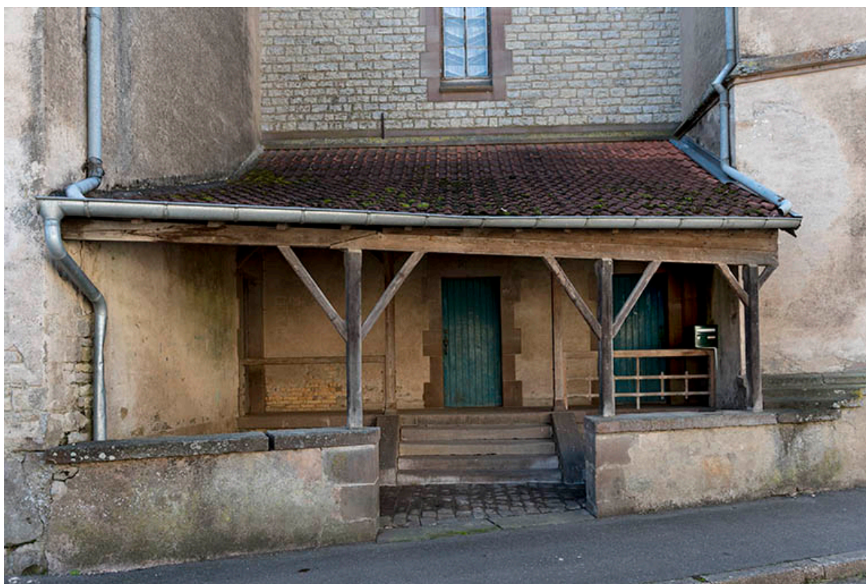
Détail de l'entrée rue Billecard.
