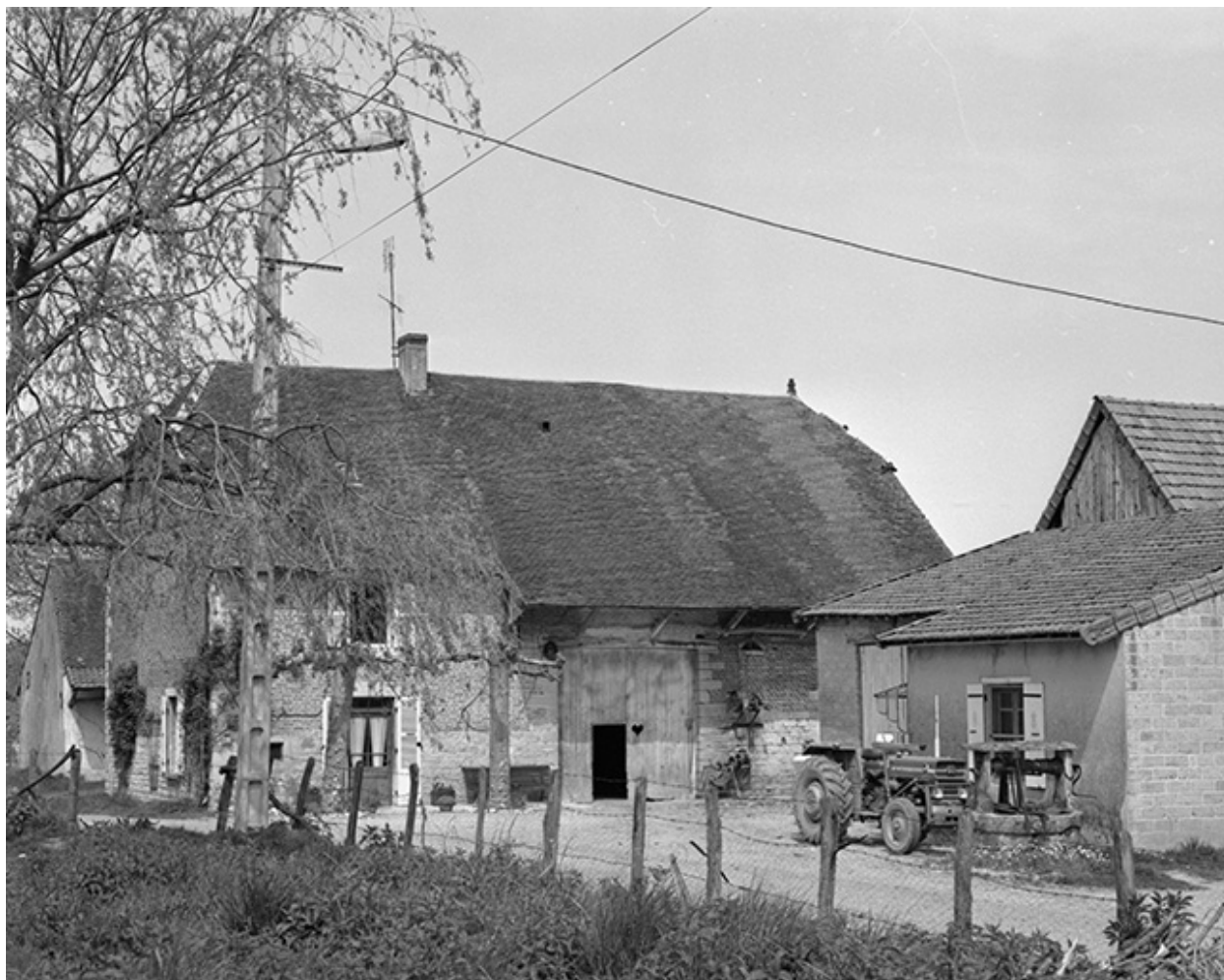
Façade antérieure et bâtiment agricole.
