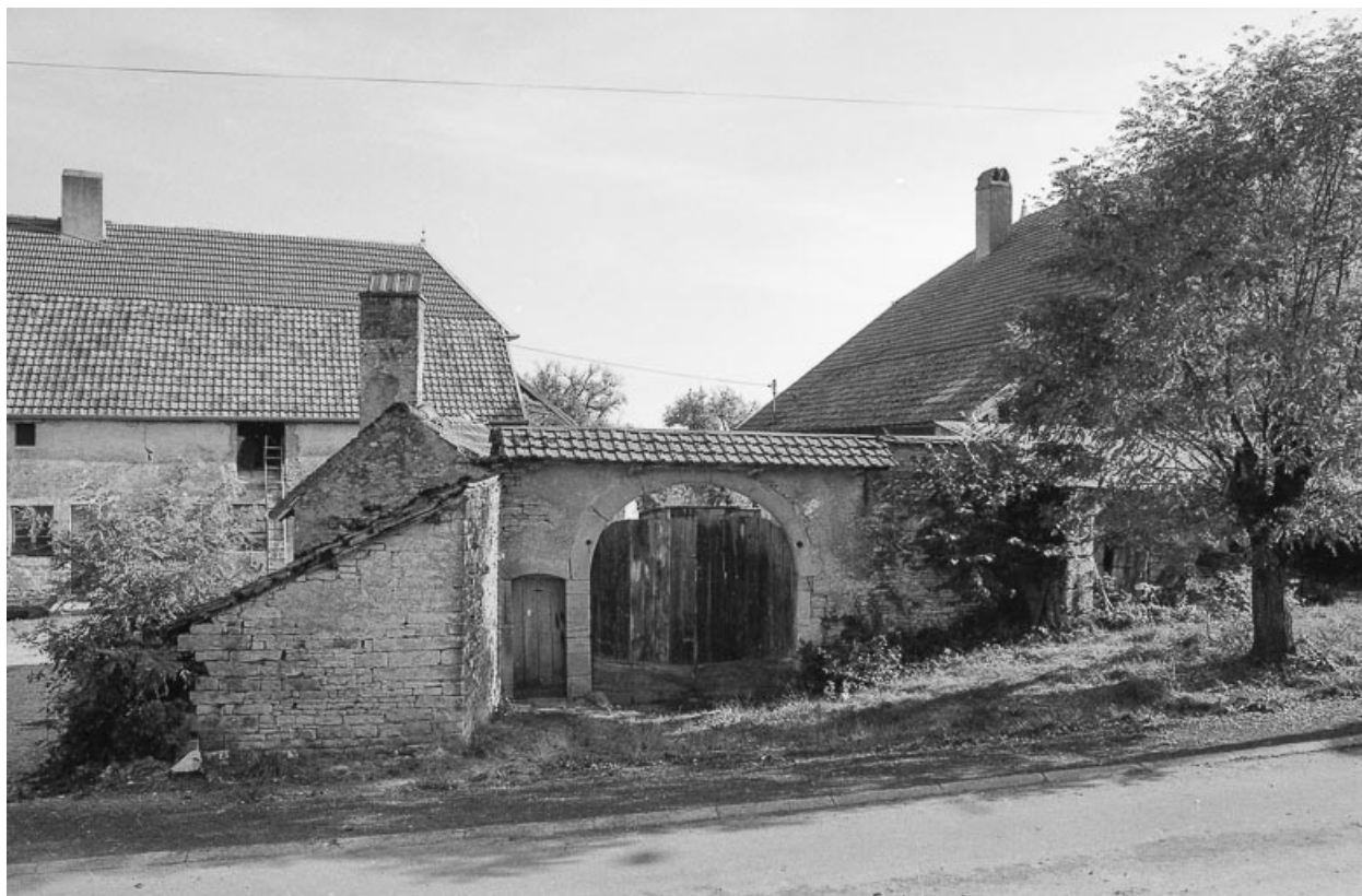
Vue du four depuis la rue.
