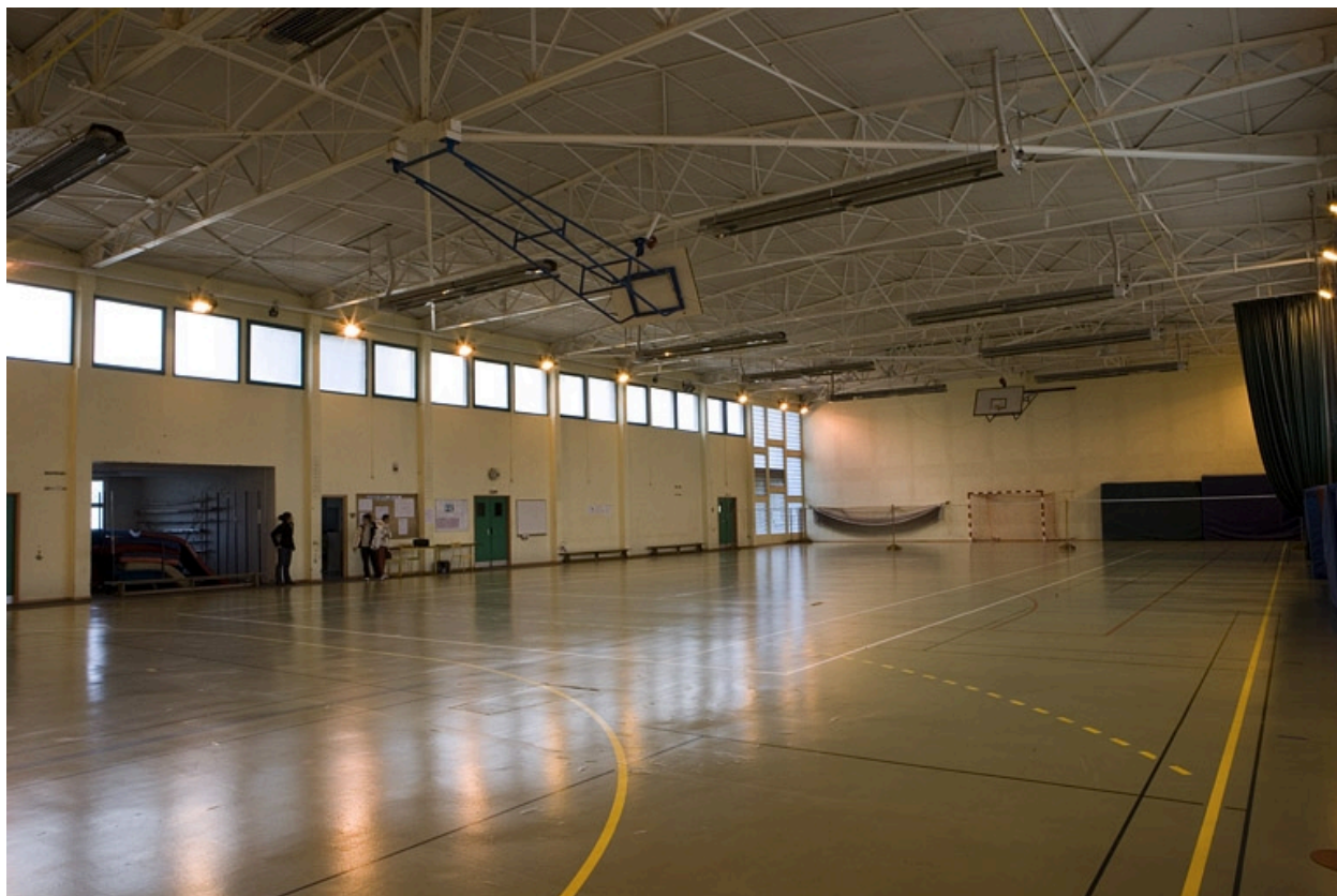
Bâtiment F1. Vue intérieure gymnase.
