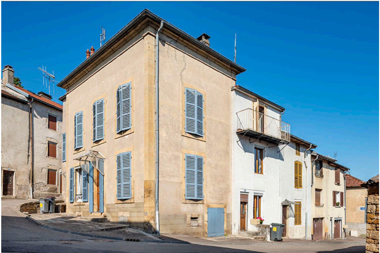
Trois quarts droit du n° 41 et des façades adjacentes de la rue Patet-Tournante.
