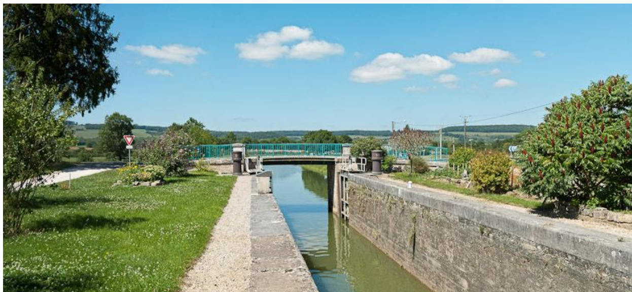
Vue du pont depuis l'amont.
