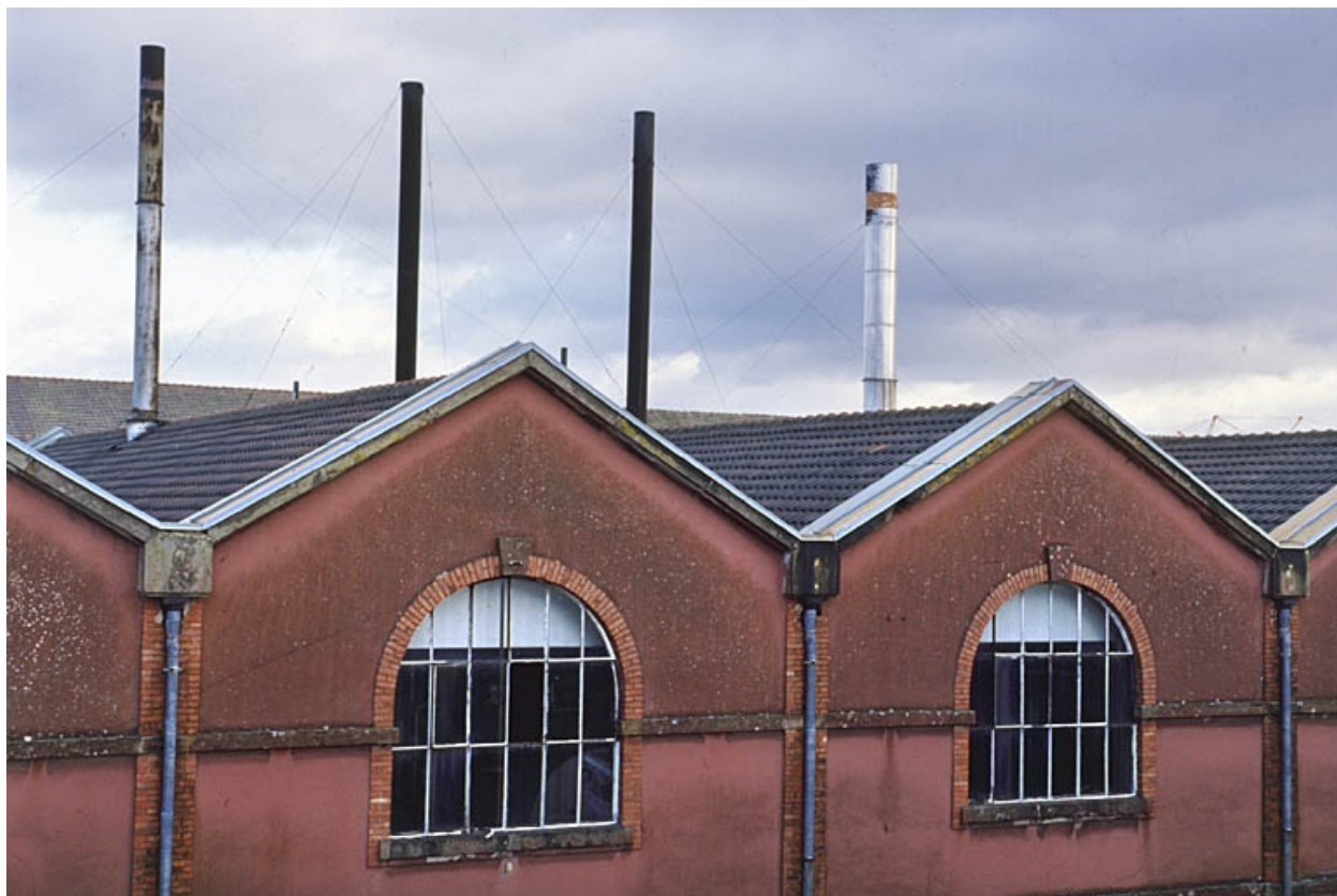
Chaudière : détail des pignons ouest.
