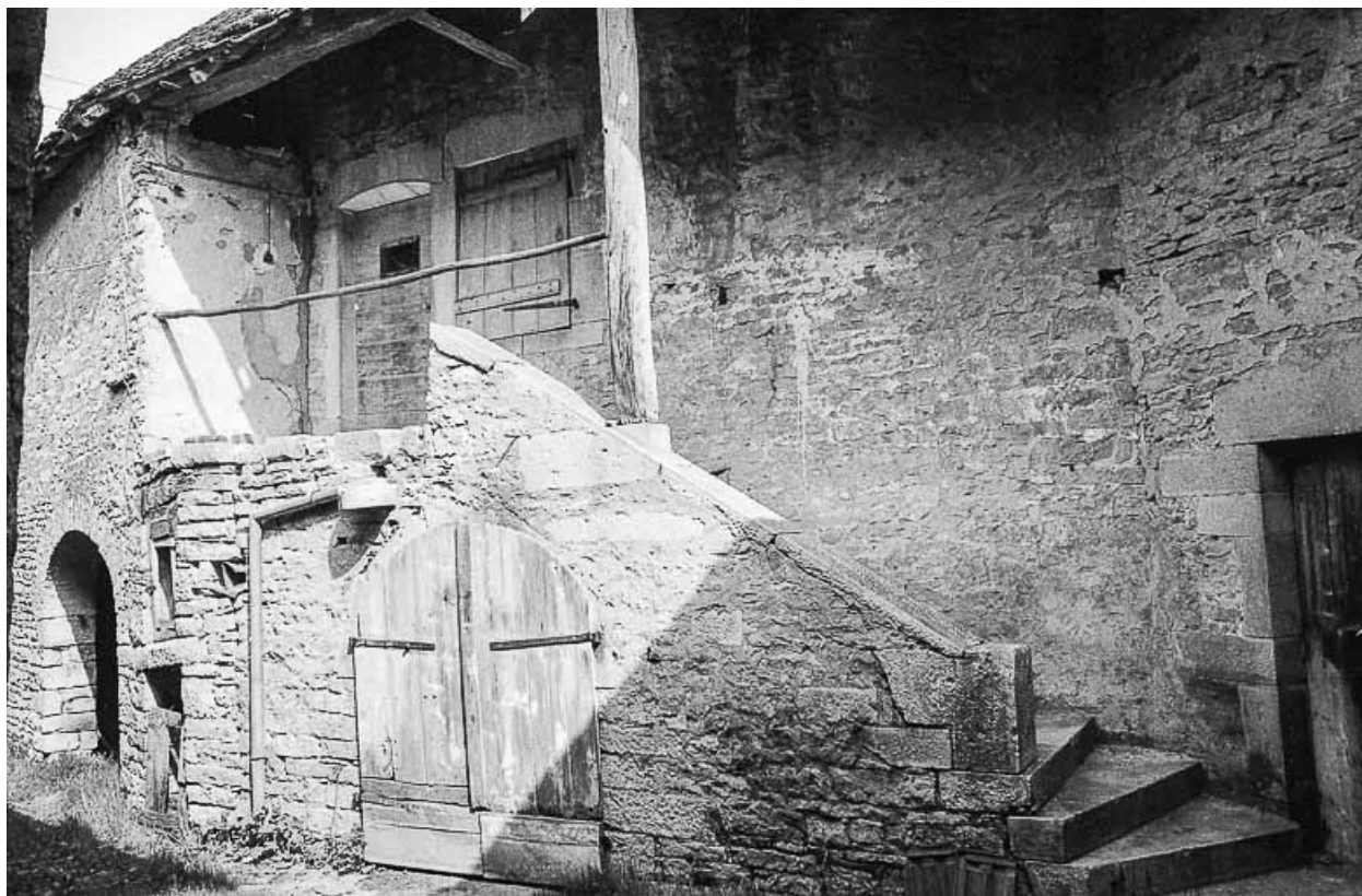
L'habitation, à gauche dans la cour.
