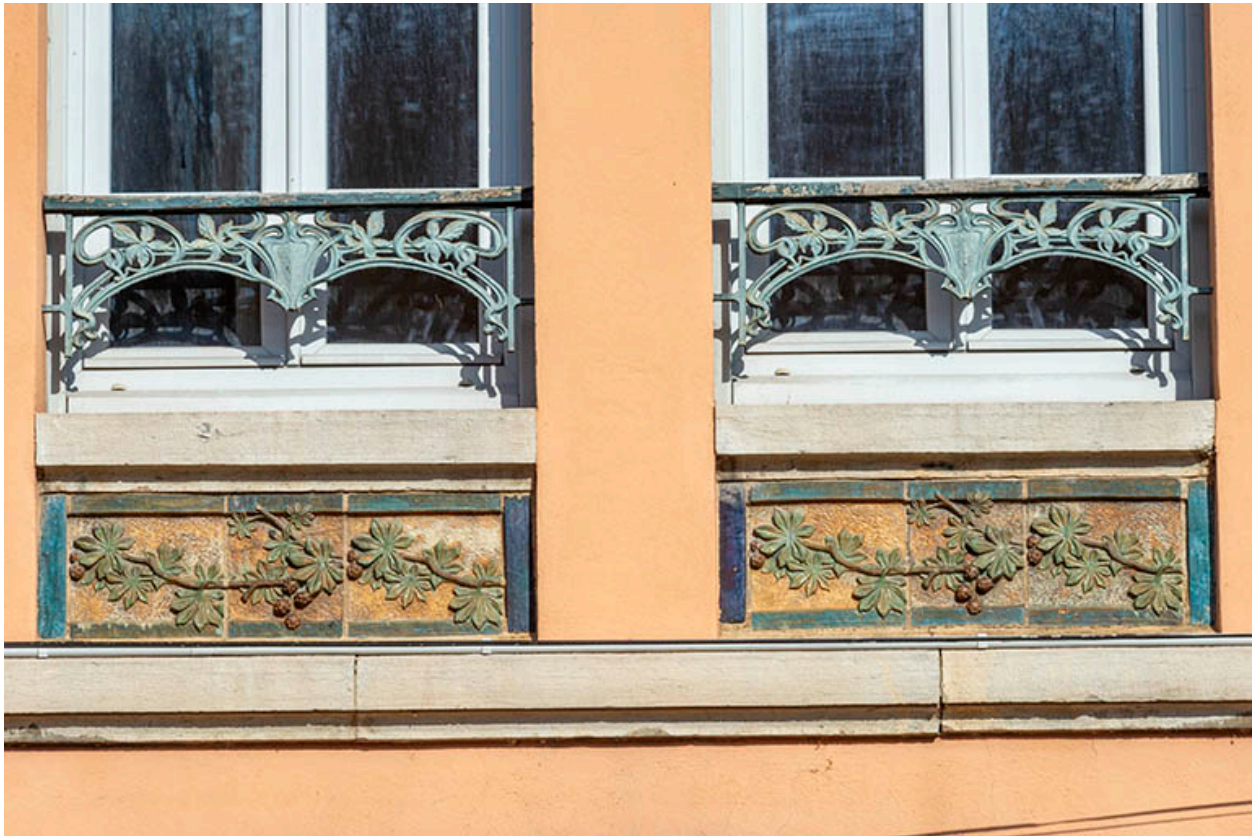
Façade nord. Détail des allèges de l'étage.
