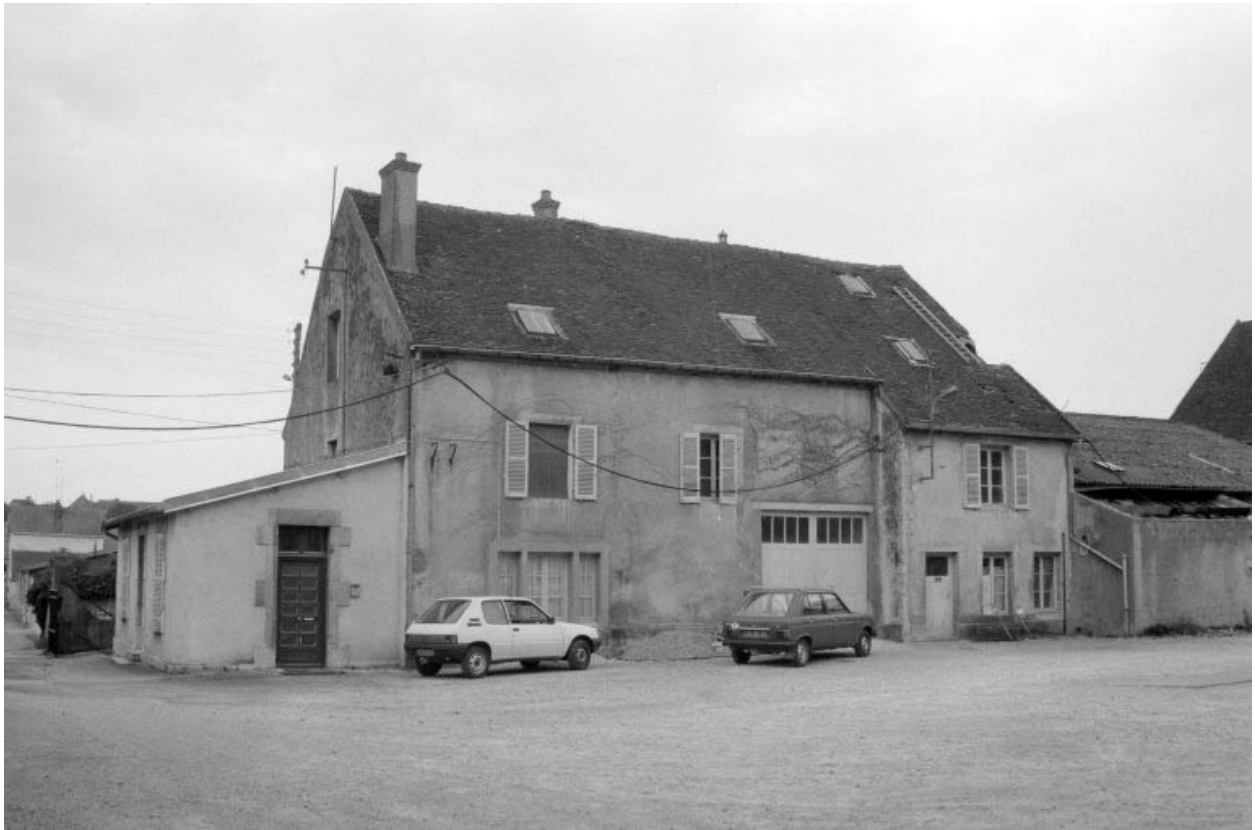
Façade postérieure du bureau-logement patronal.
