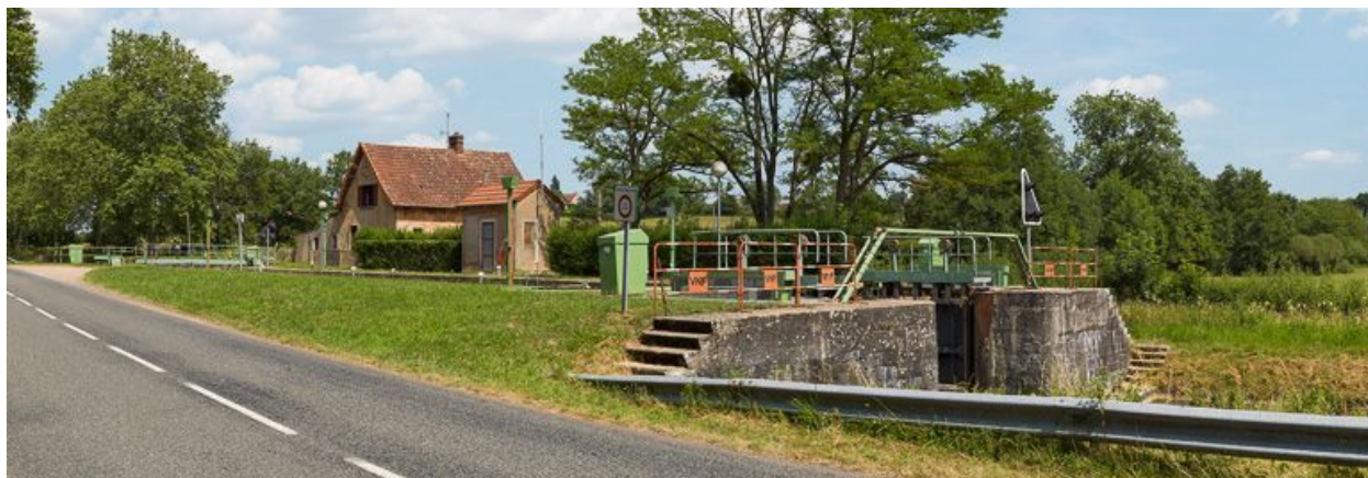
Vue d'ensemble, prise d'aval.
