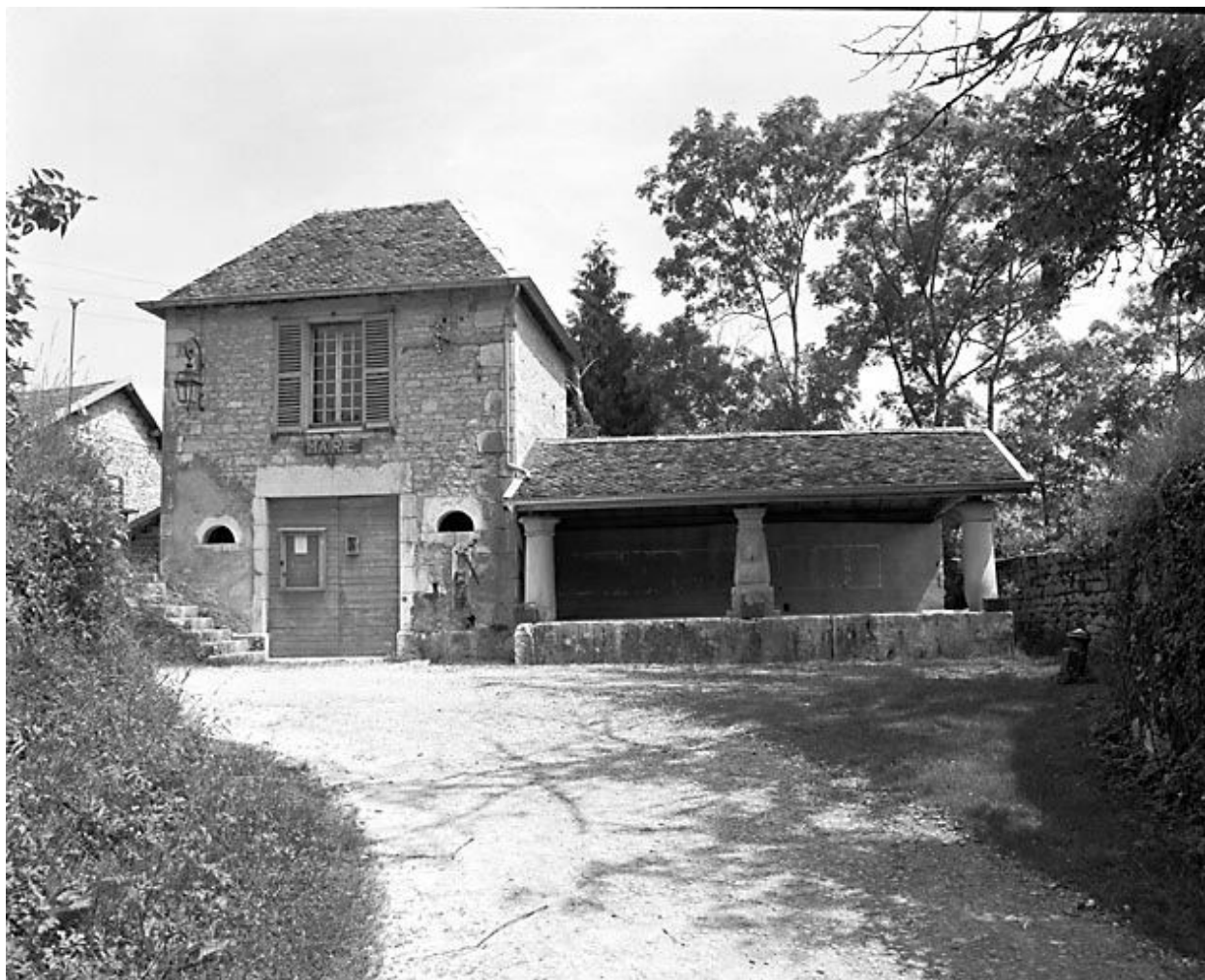
Fontaine-lavoir située rue des Vignerons.
