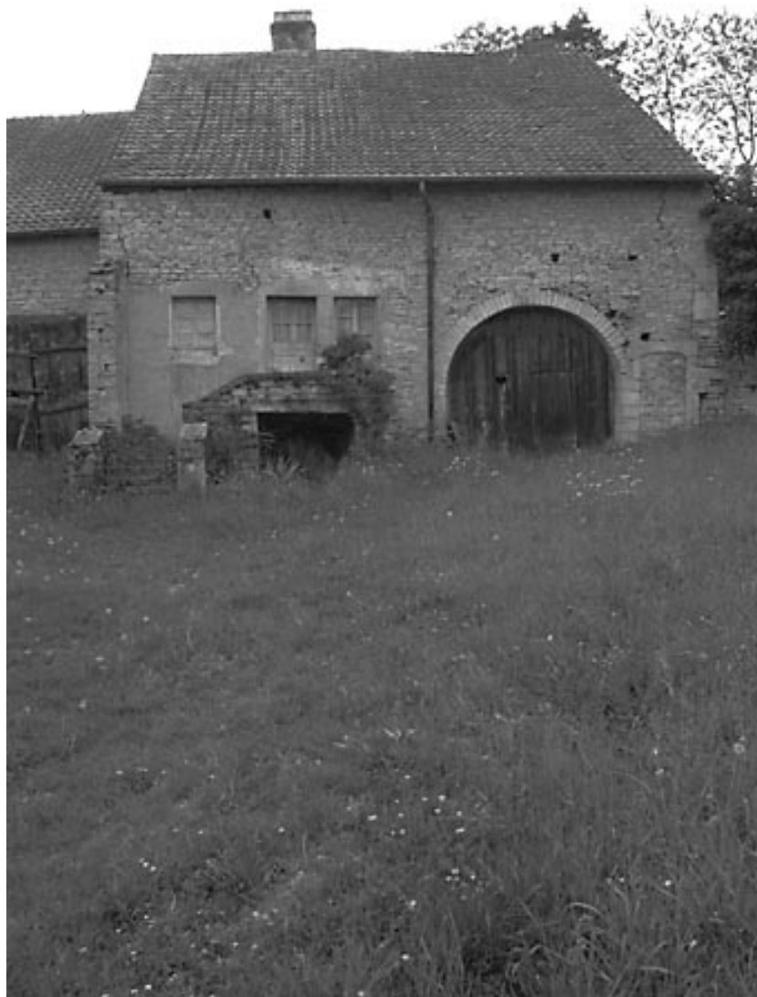
Façade antérieure sur cour.
