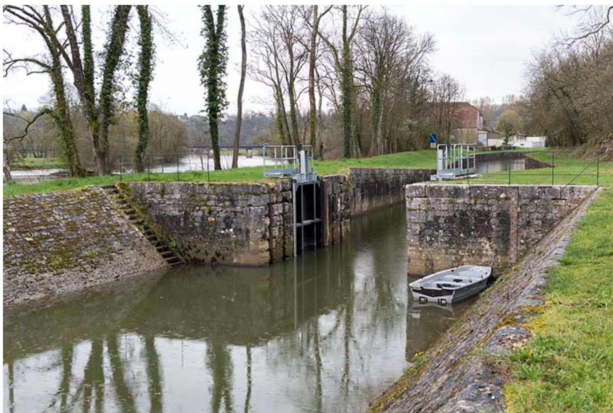
La maçonnerie de la porte de garde.
