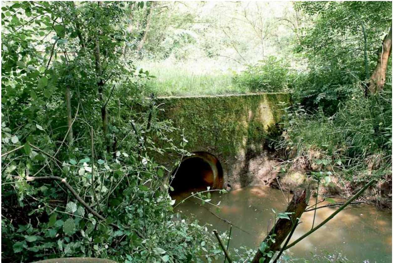
Vue d'ensemble d'un ponceau à Rancy.
