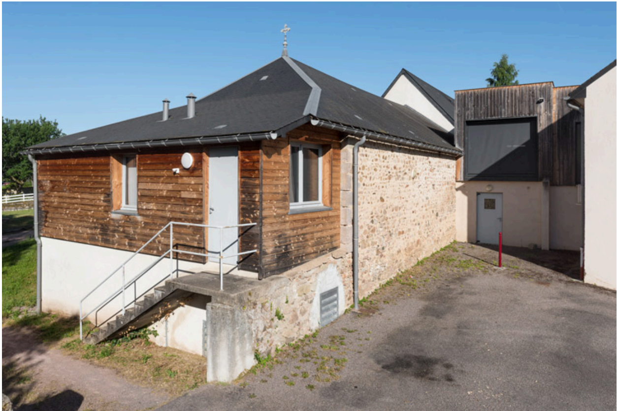
Façades postérieure et latérale gauche.
