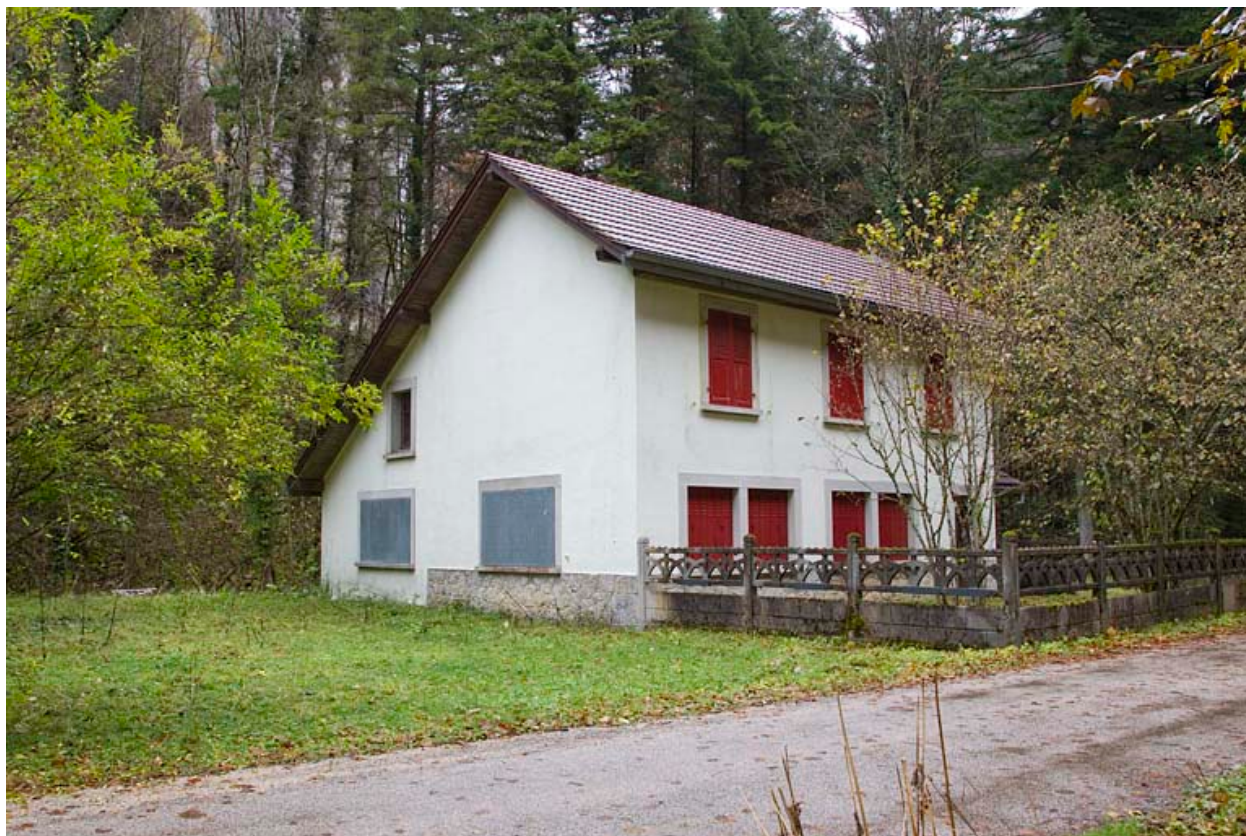
Ancienne école, vue de trois quarts gauche.
