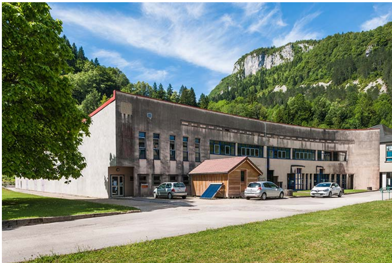
Atelier, ancien atelier mécanique : vue d'ensemble.
