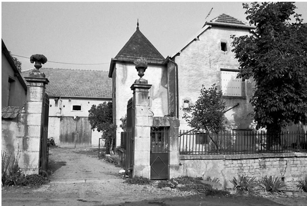
Ferme située Grande Rue à Vantoux.
