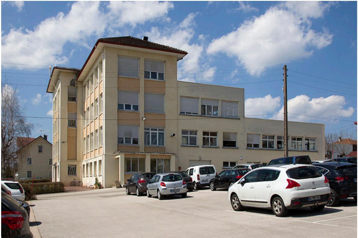
Façade latérale droite.
