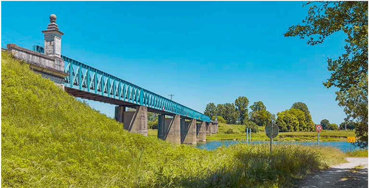
Vue d'ensemble du pont.
