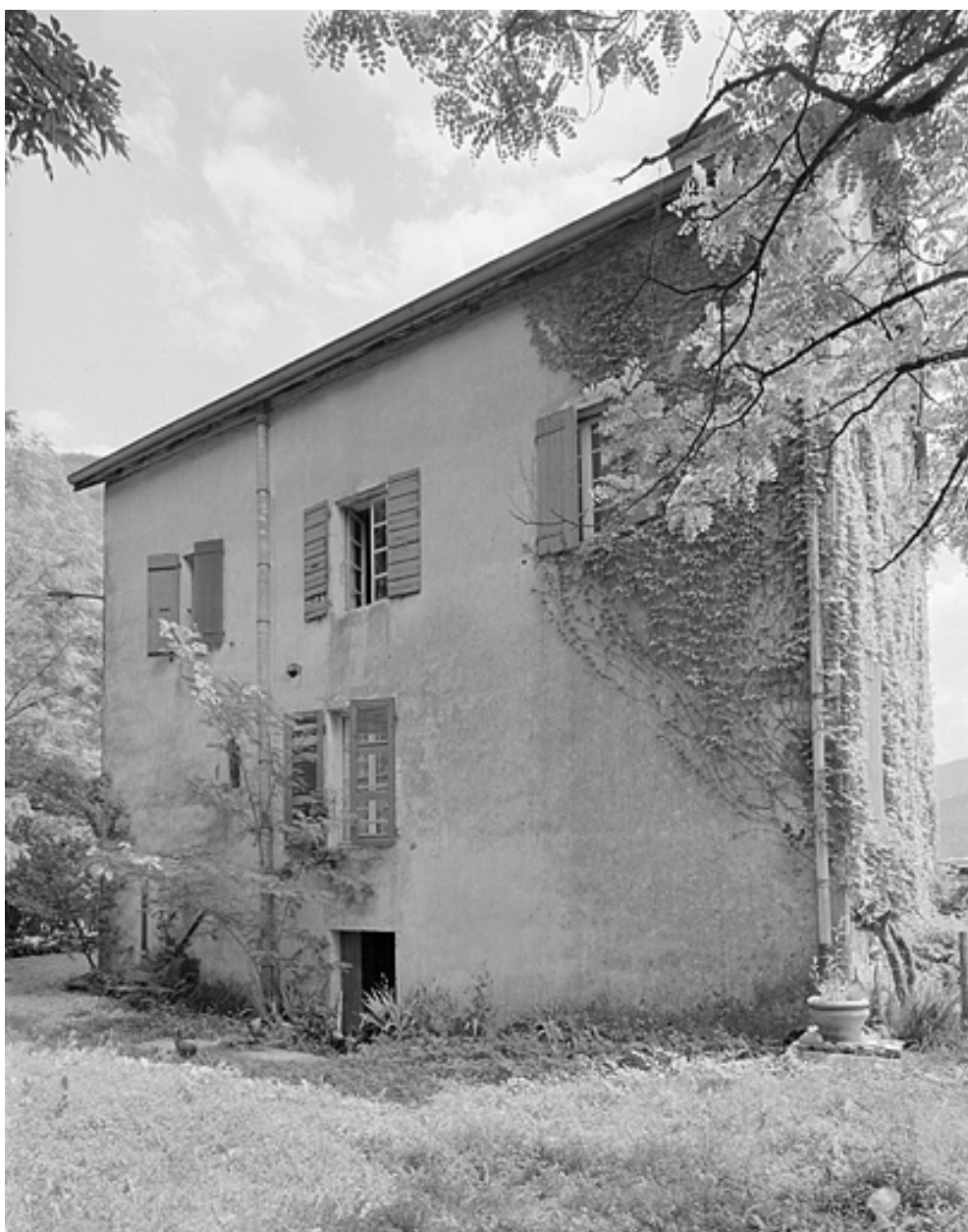
Façade droite avec accès au sous-sol.
