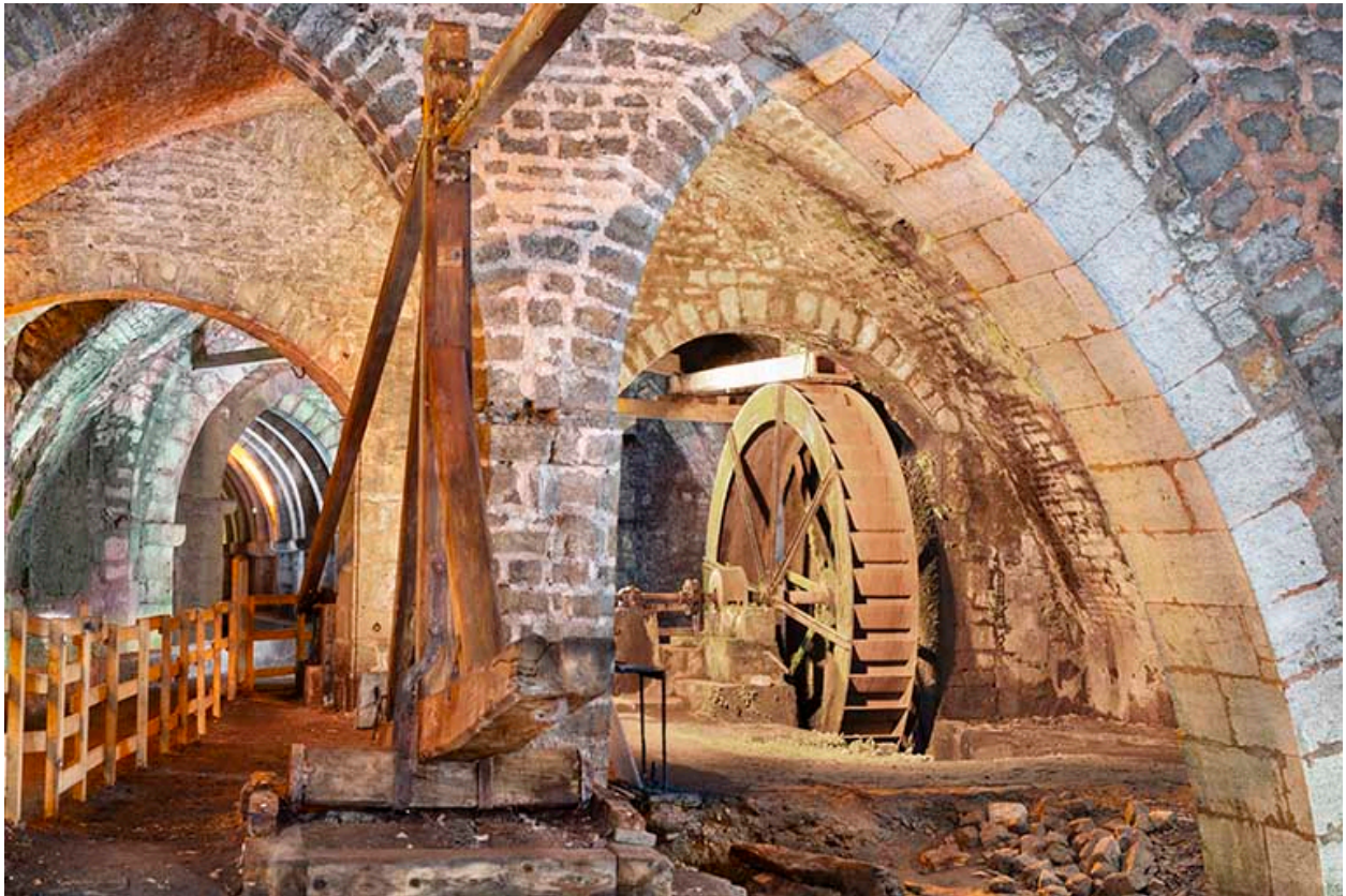
Puits d'Amont. Mécanisme hydraulique : roue à eau et balancier d'équilibre.
