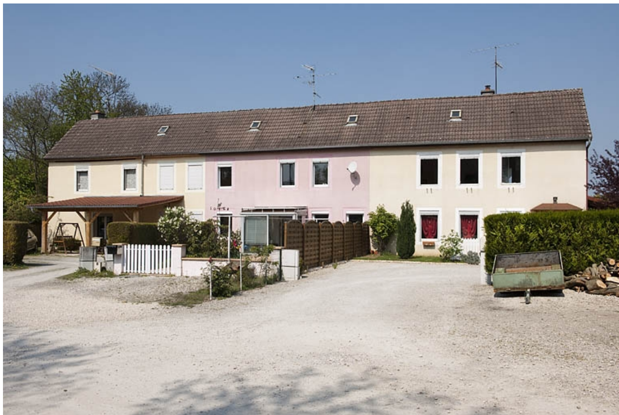
Bâtiment des magasins, remises et logements.
