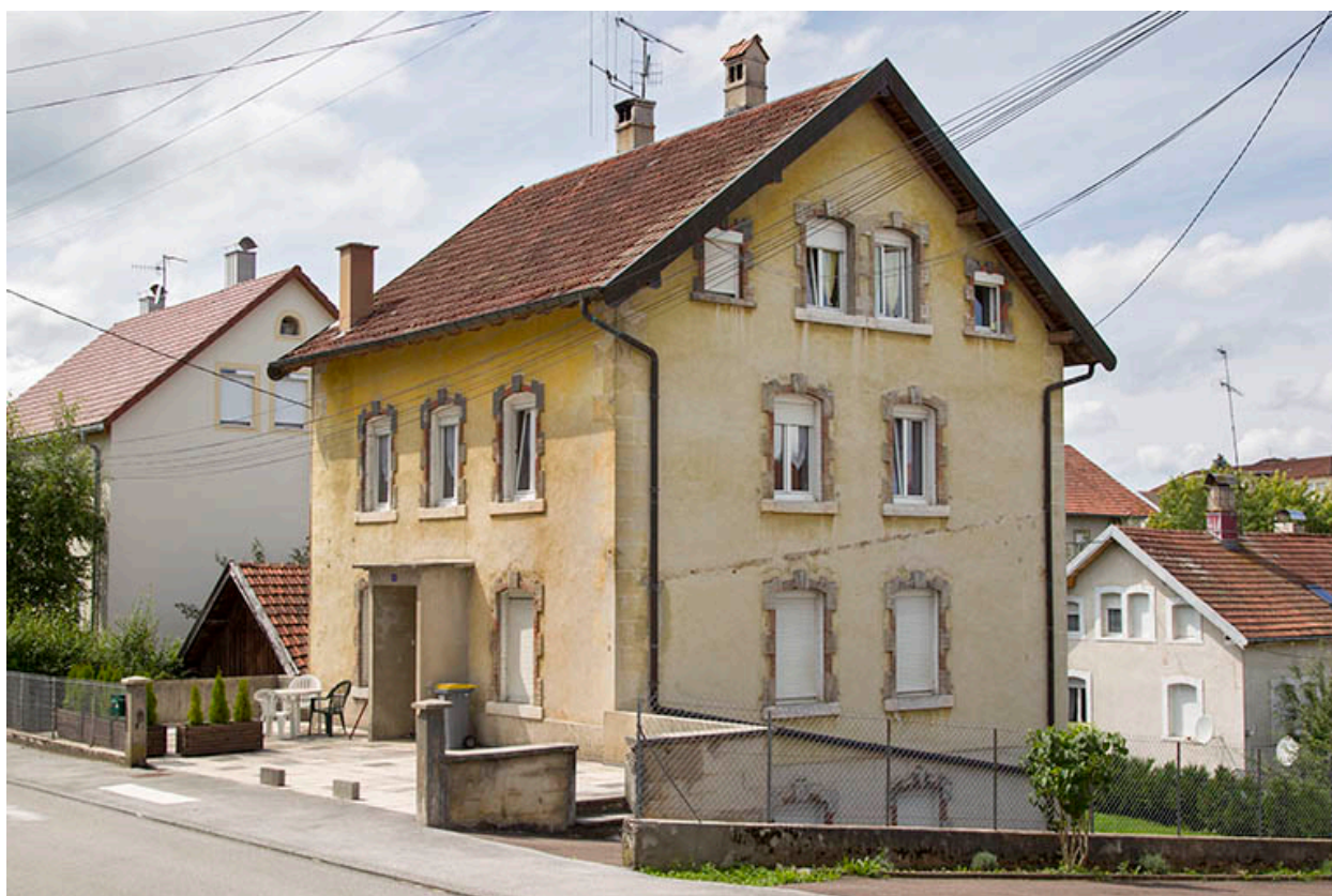
Façades antérieure et latérale droite.
