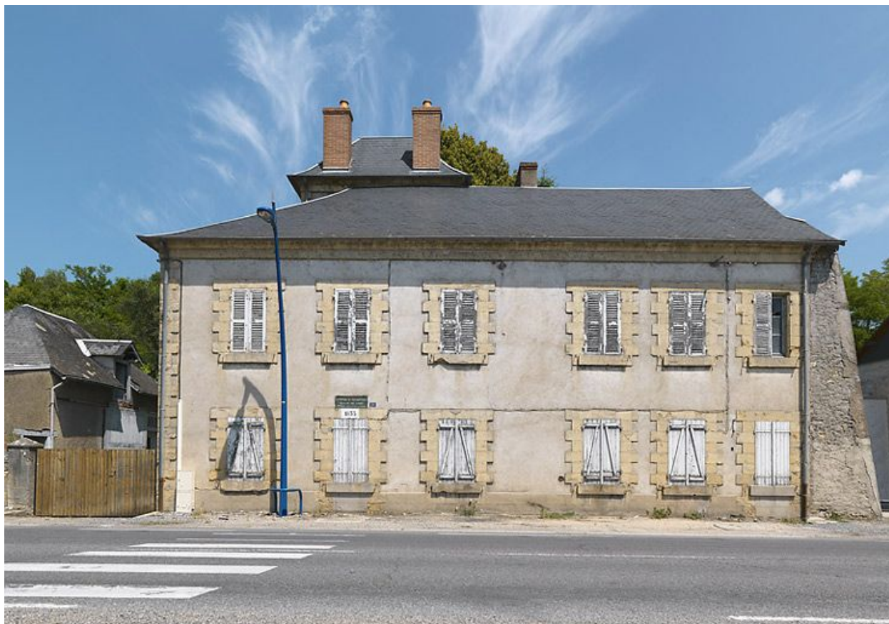
La maison éclusière, vue de face.
