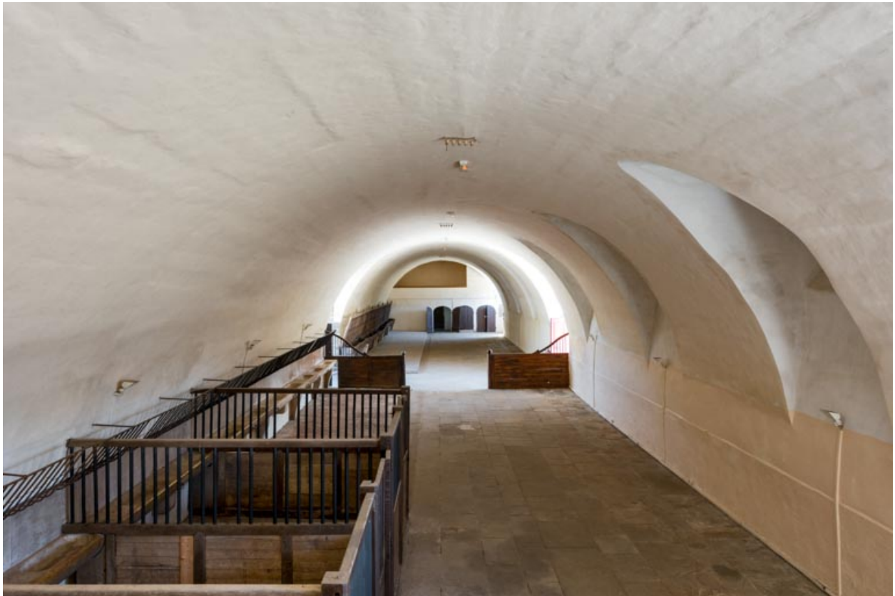
Ecurie : la voûte depuis la tribune occidentale.
